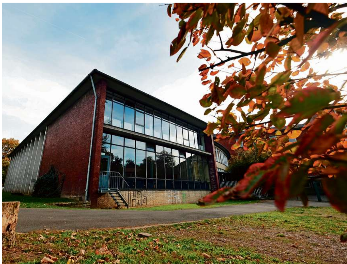
Die alte Einfachhalle an der Märkischen Schule wird ab 2020 abgerissen, anschließend entsteht dort eine moderne Dreifachturnhalle.
